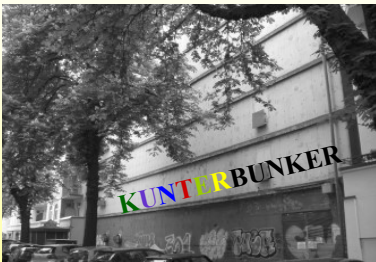
Hochbunker im Kuhnsweg
