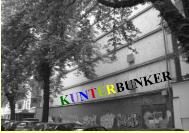
Hochbunker im Kuhnsweg
